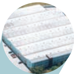
Завод по производству труб, г. Берлин, Германия
